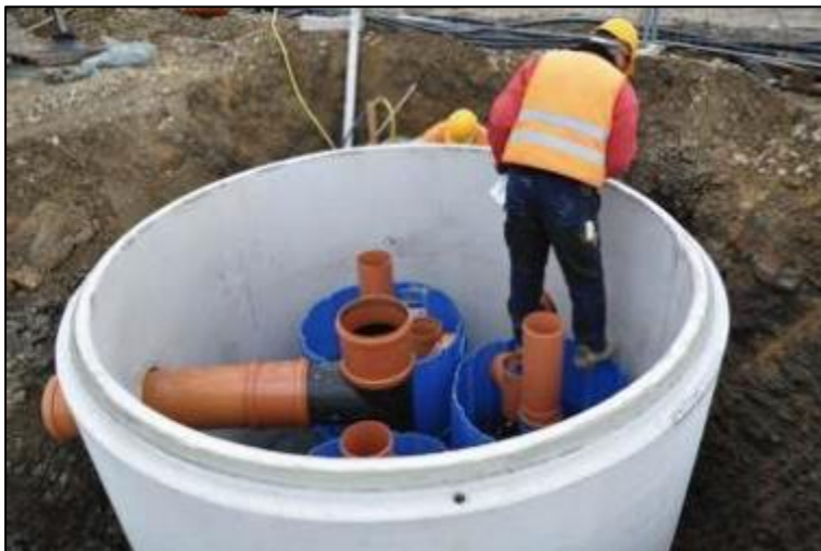
Figur 20. Filterinsatser förlagda i dagvattenbrunn.
