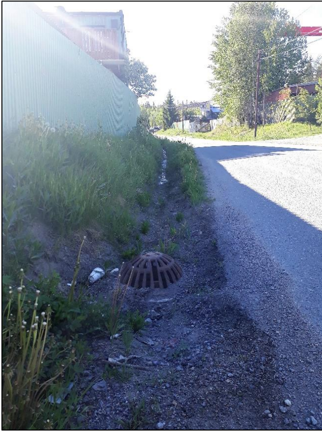
Figur 9. Öppet dike samt en dagvattenbrunn vid korsningen Lagervägen/Upplagsvägen (Foto: Norconsult, 2017-06-02)
