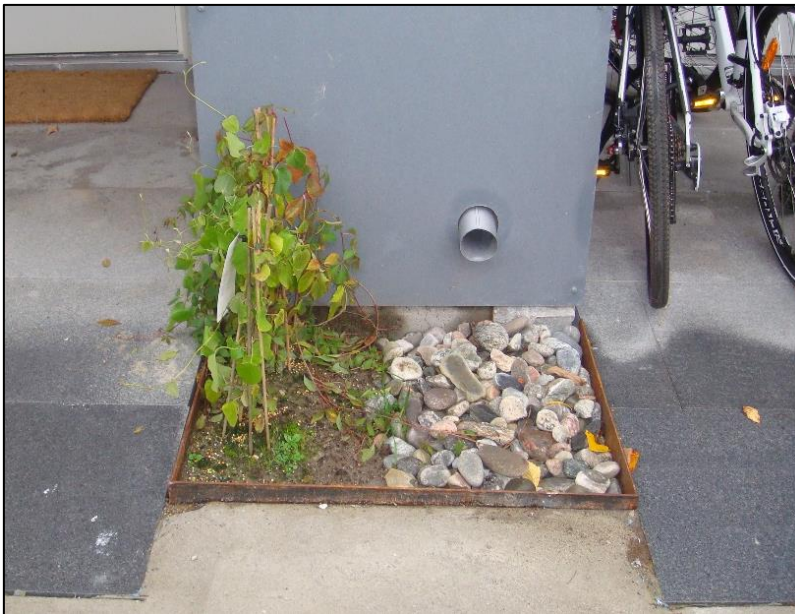
Figur 28. Exempel på utformning av regnbädd där takvattnet leds direkt till regnbädden (Foto: Norconsult)
