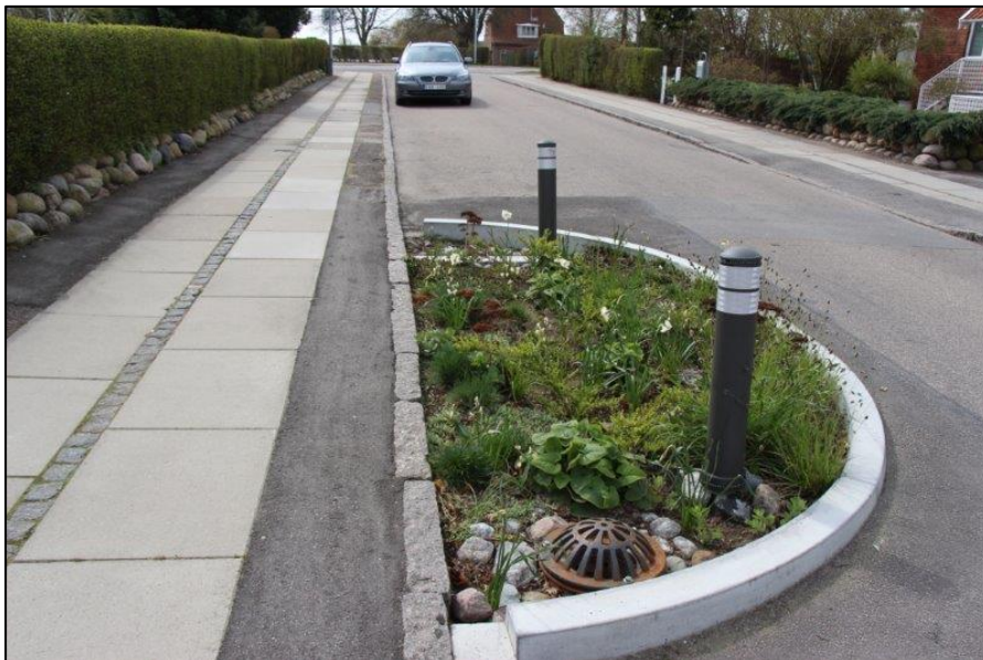
Figur 29. Exempel på utformning av regnbädd där dagvattnet avleds till grönytan via en öppning i kantstenen (Foto: Norconsult)
